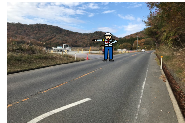
(主)吉田豊栄線との接合部の 工事用車両出入口より出入りがあります。
