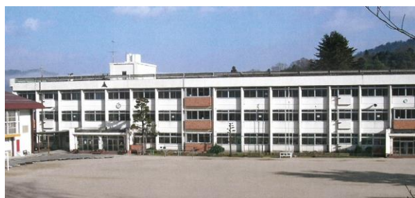
校舎等の外観写真
