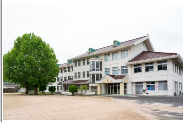
校舎等の外観写真
