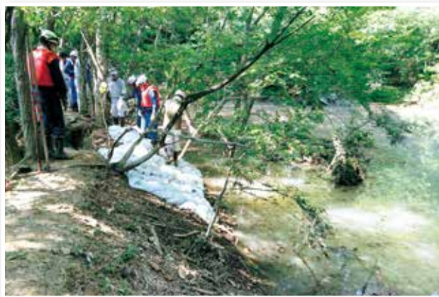
応急的に補強したため池
